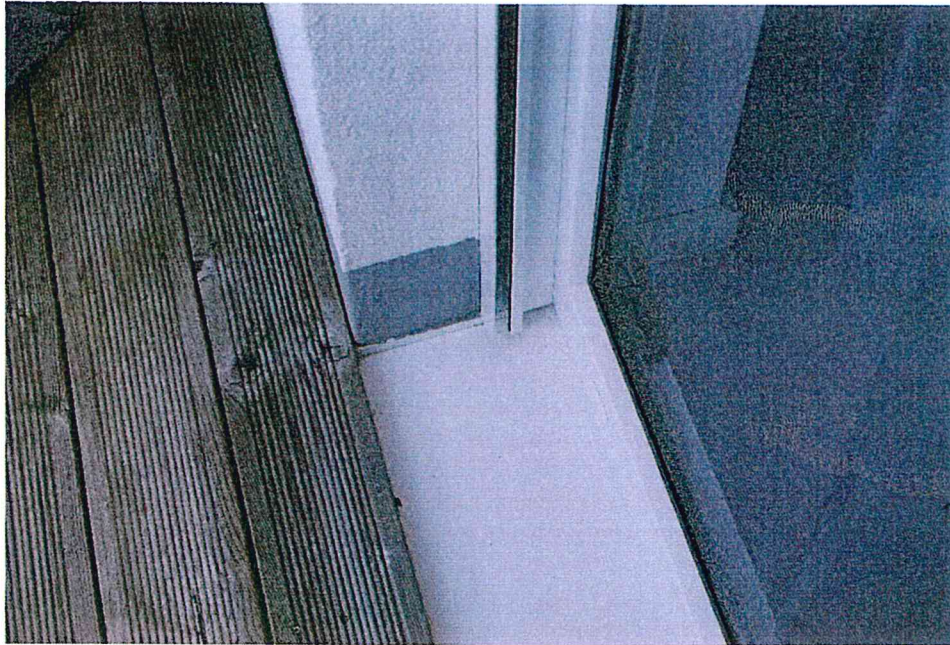
Abb. 5 Seitlicher Anschluss Bodenblech bei Terrassentüre Schlafzimmer
